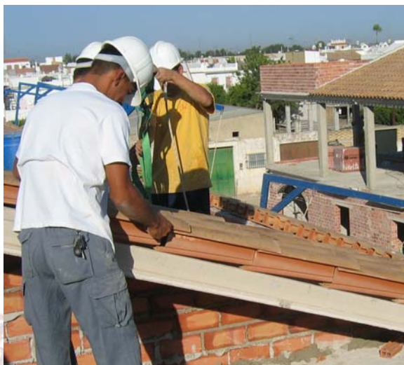
Fotografía 22 y Fotografía 23. Teja con estructura celular sobre vigueta de hormigón
