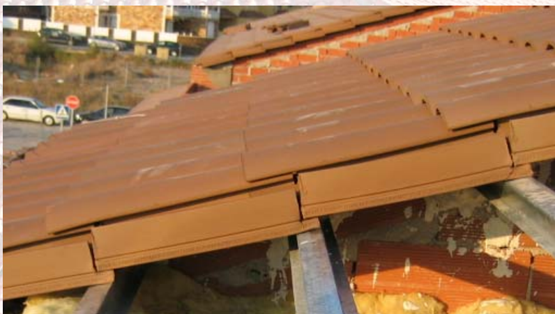
Fotografía 14. Teja con estructura celular. Apoyo sobre rastreles metálicos
