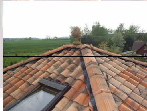
Fotografía 8 y Fotografía 9. Cumbre y limatesas ventiladas para evitar daños por acumulación de humedad
