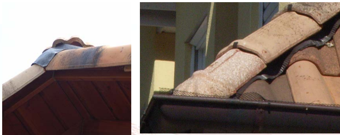
Fotografía 31 y Fotografía 32. Encuentro de limatesa con borde lateral y alero teja mixta)
