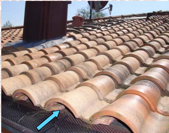
Fotografía 5 y Fotografía 6. Alero libre para permitir la microventilación
