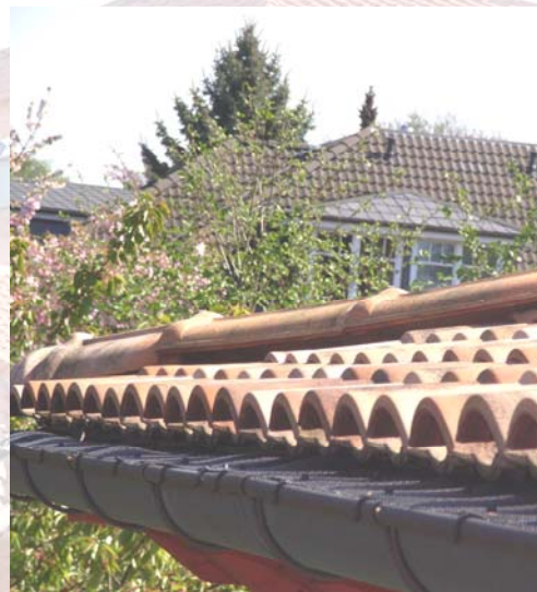
Figura 62 y Fotografía 24. Alero horizontal con canalón visto
