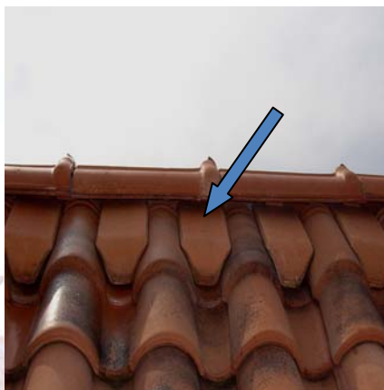
Fotografía 27. Cuñas para ventilación de cumbre
