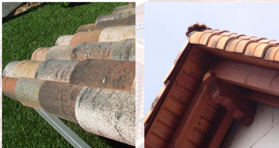
Fotografía 34 y Fotografía 35. Remate lateral (teja curva y mixta)
