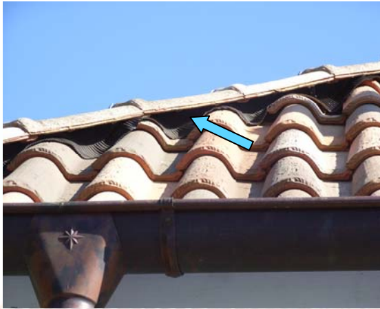
Fotografía 10 y Figura 33. Limatesa ventilada para evitar acumulación de humedad bajo teja
