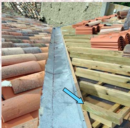
Fotografía 3. Ejecución de limahoya. El espacio entre rastreles y tejas debe quedar libre.
