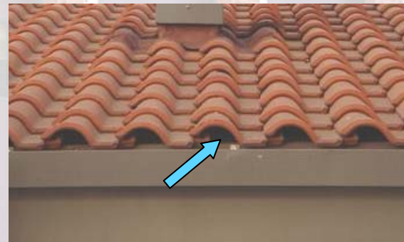
Fotografía 5 y Fotografía 6. Alero libre para permitir la microventilación
