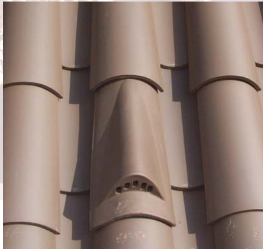
Fotografía 12. Teja de ventilación
