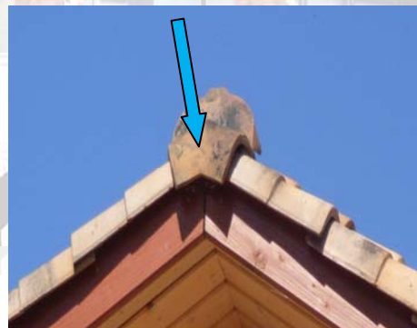
Fotografía 28 y Fotografía 29. Remate lateral. Pieza especial remate lateral caballete
