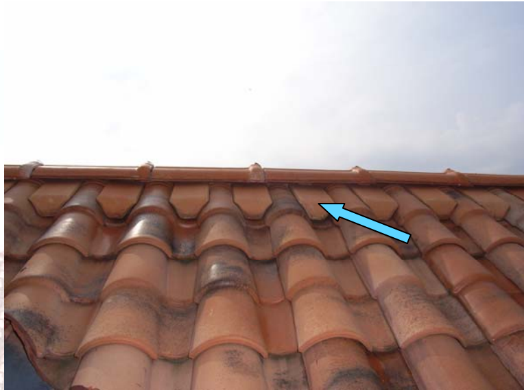
Fotografía 11. Cuñas para ventilación de cumbre
