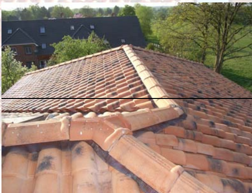
Fotografía 8 y Fotografía 9. Cumbre y limatesas ventiladas para evitar daños por acumulación de humedad
