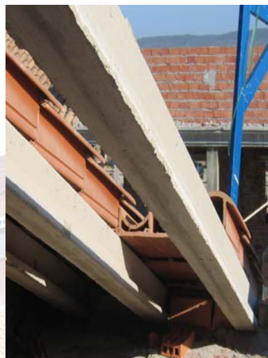
Fotografía 22 y Fotografía 23. Teja con estructura celular sobre vigueta de hormigón
