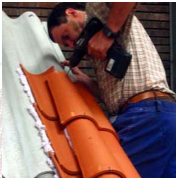
Fotografía 21. Teja fijada con espuma de poliuretano y clavo
