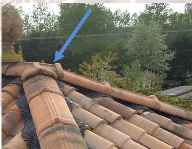
Fotografía 33. Encuentro de limatesas y cumbre. Caballete a tres aguas
