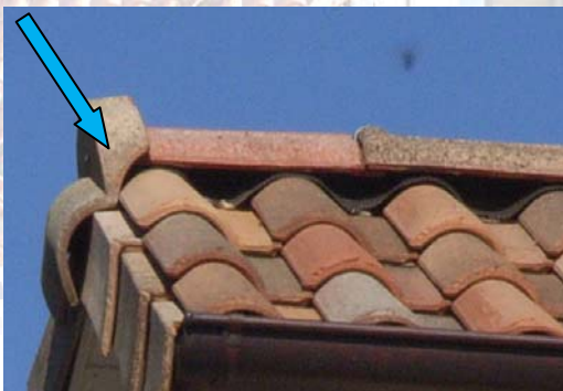
Fotografía 28 y Fotografía 29. Remate lateral. Pieza especial remate lateral caballete
