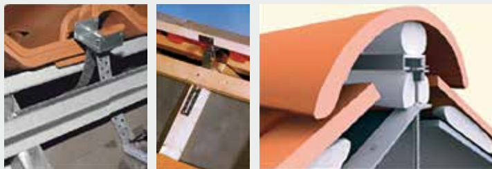
Instalación de diferentes soportes de caballete para conseguir la microventilación en cumbrera y limatesas
