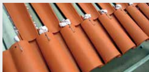
Fijación de tejas cobija con gancho de teja curva y un punto de espuma
