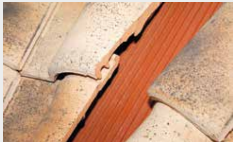
Limahoya con espacio libre bajo teja para permitir la microventilación
