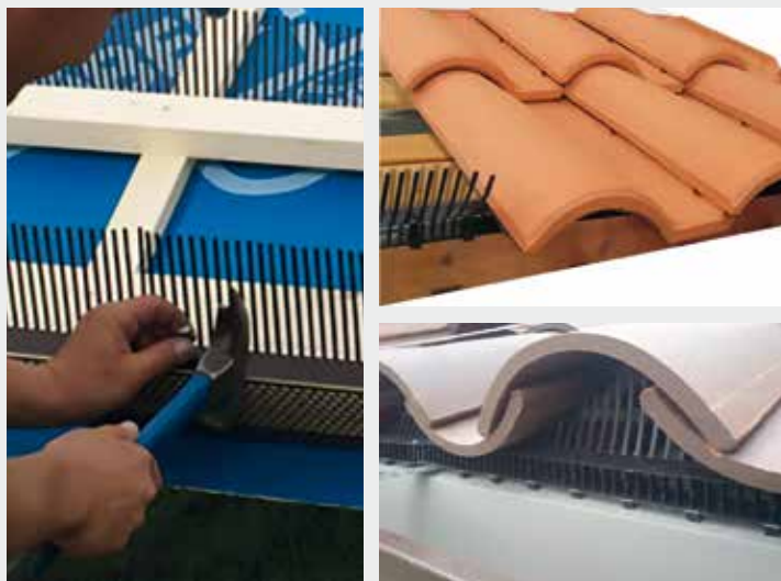
Alero con peines de alero para permitir la entrada de aire de la microventilación
