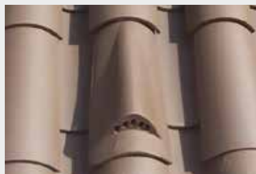
Colocación de teja de ventilación
