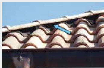
Cumbrera y limatesas microventiladas para evitar daños por acumulación de humedad
